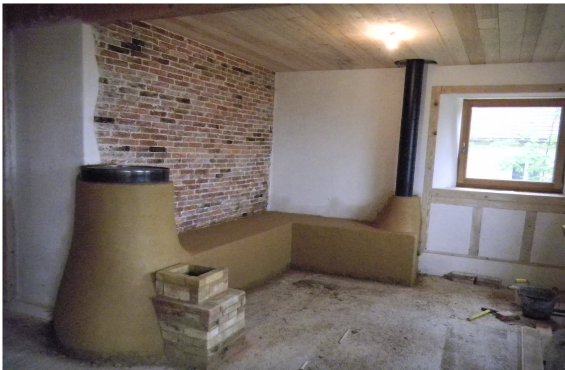
Exemple de réalisation d'un rocket de masse
